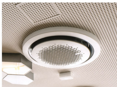
Montáž v podhledu
